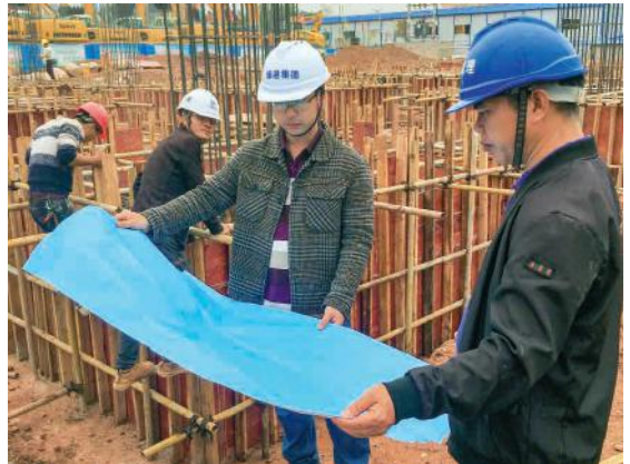
杨进（右二）在项目现场协调工作
